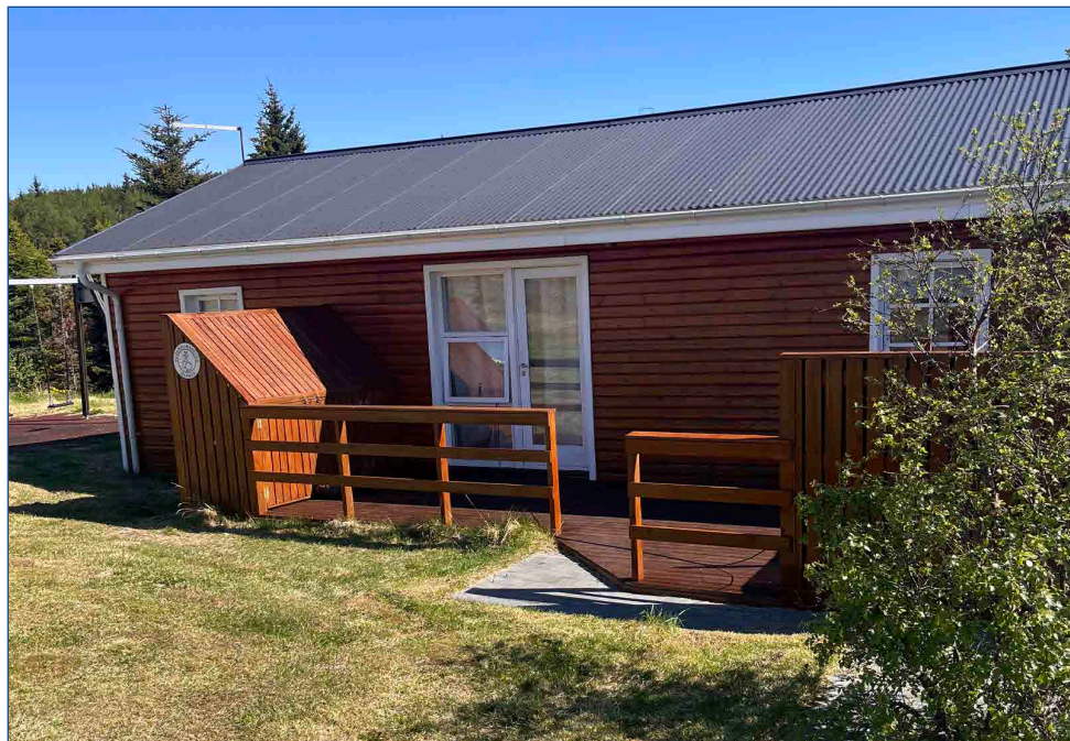
Orlofshúsið í Varmahlíð - Reykjarhólsvegur 18-B.
